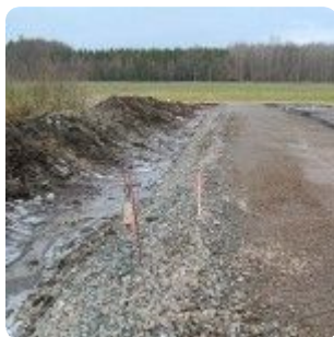
Auf dem Dam wird noch ein Überlauf und ein Unterhaltungsweg gebaut
