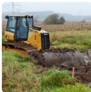
Im Spätherbst 2012 begannen die Mitarbeiter des Bereichs Sanierung Ronneburg mit der Schlammberäumung
