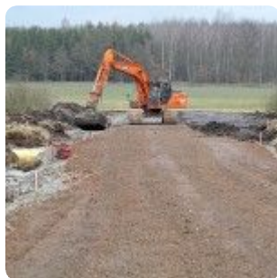
Die Wismut GmbH errichtet einen Sedimentfang im Naturschutzgebiet Frießnitzer See-Struth
