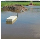
Ende Mai 2013 mussten die Arbeiten aufgrund des Hochwassers unterbrochen werden
