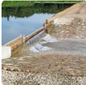
Überlauf und Dammscharte
