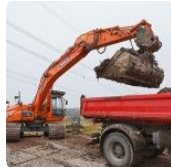
Im Spätherbst 2012 begannen die Mitarbeiter des Bereichs Sanierung Ronneburg mit der Gründung des Damms
